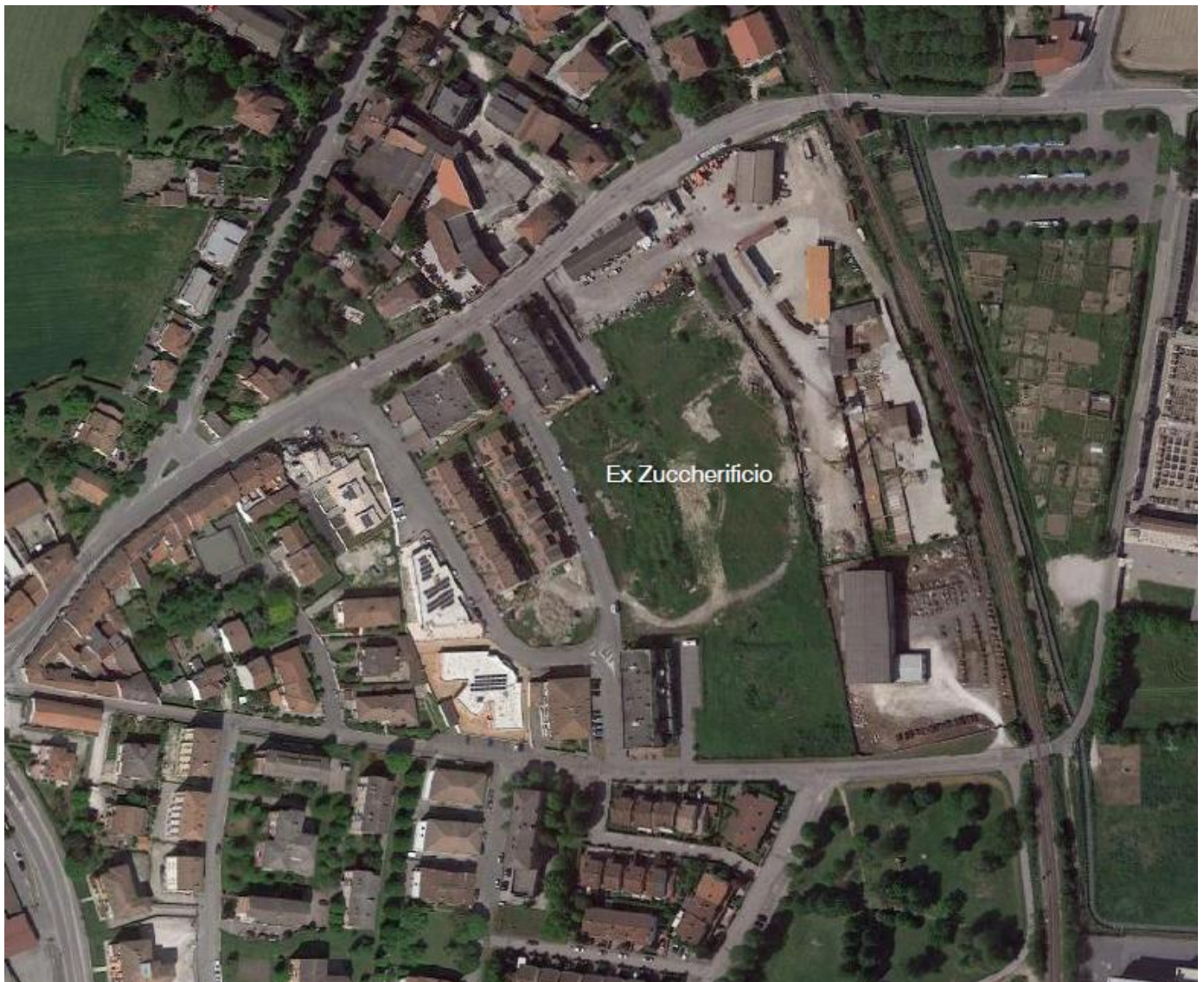
Figura 3.1-1 – Ortofoto 2018 dell'area in esame
